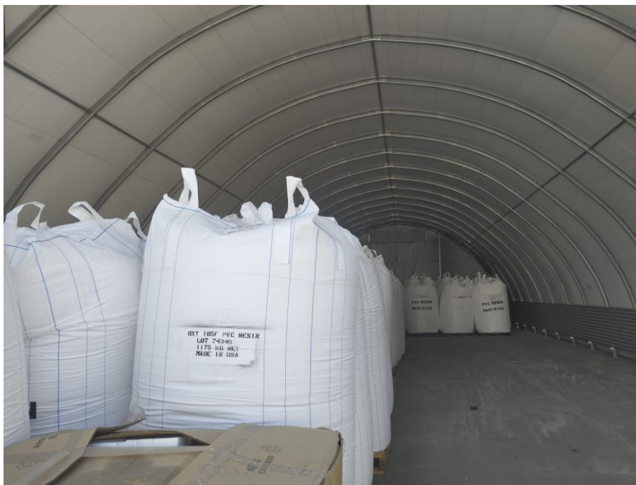
Figure 20 : Tunnel de stockage pouvant accueillir des matières premières conditionnées, ici en big bags
