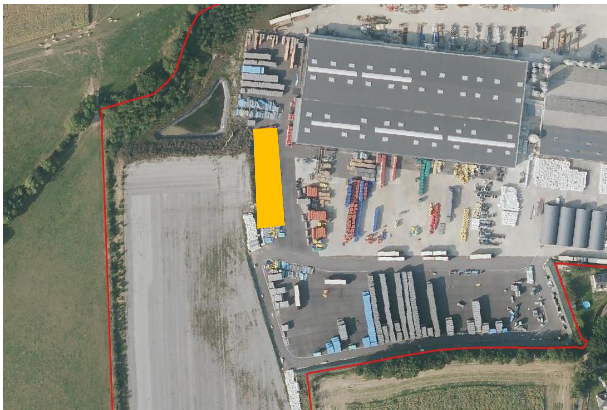
Figure 26 : Emplacement du dépôt de bois (Source : IGN)
